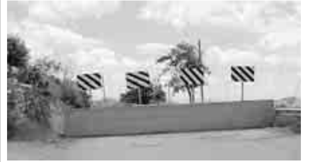
LA BARRIERA DI CEMENTO COLLOCATA SULLA SS 288
