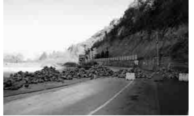
F. G. LE CONDIZIONI DELLA STRADA PANORAMICA DOPO IL CROLLO
