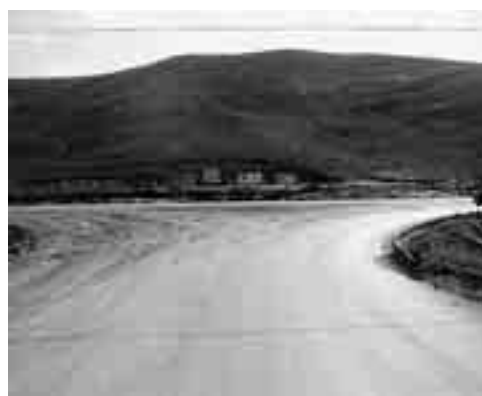
Un tratto della strada provinciale di Dittaino invasa dal fango
