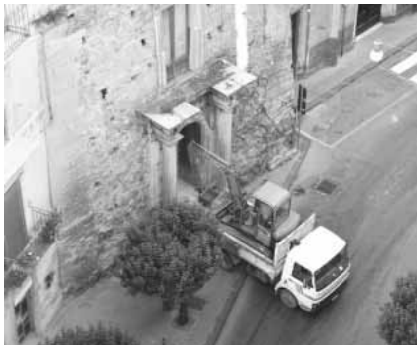
L'INIZIO DEI LAVORI NELLA SCUOLA
