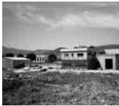
I CAPANNONI DI CONTRADA PANTANO
